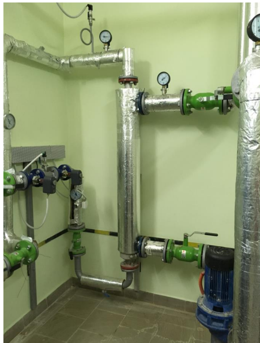
Рисунок 9. Элементы схемы ИТП на базе кожухотрубных теплообменных аппаратов
